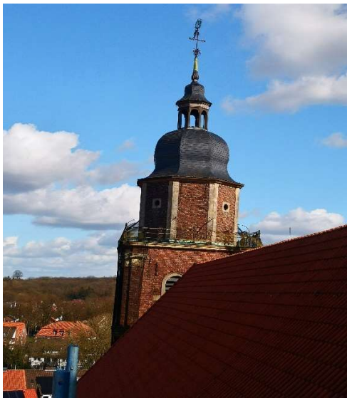
Blick von oben zum Kirchturm
